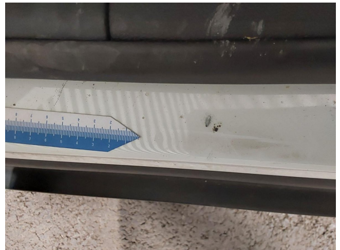
Einstieg VL delle - Instandsetzen
