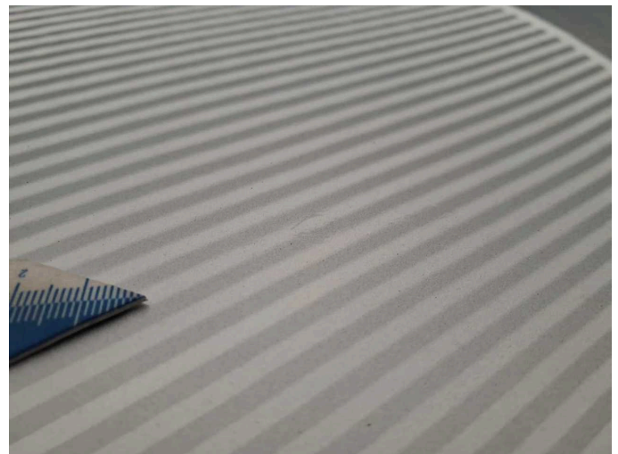
Damage 9: Roof: Roof (Verätzung und Rost) - Paint defect - Repair and paint
