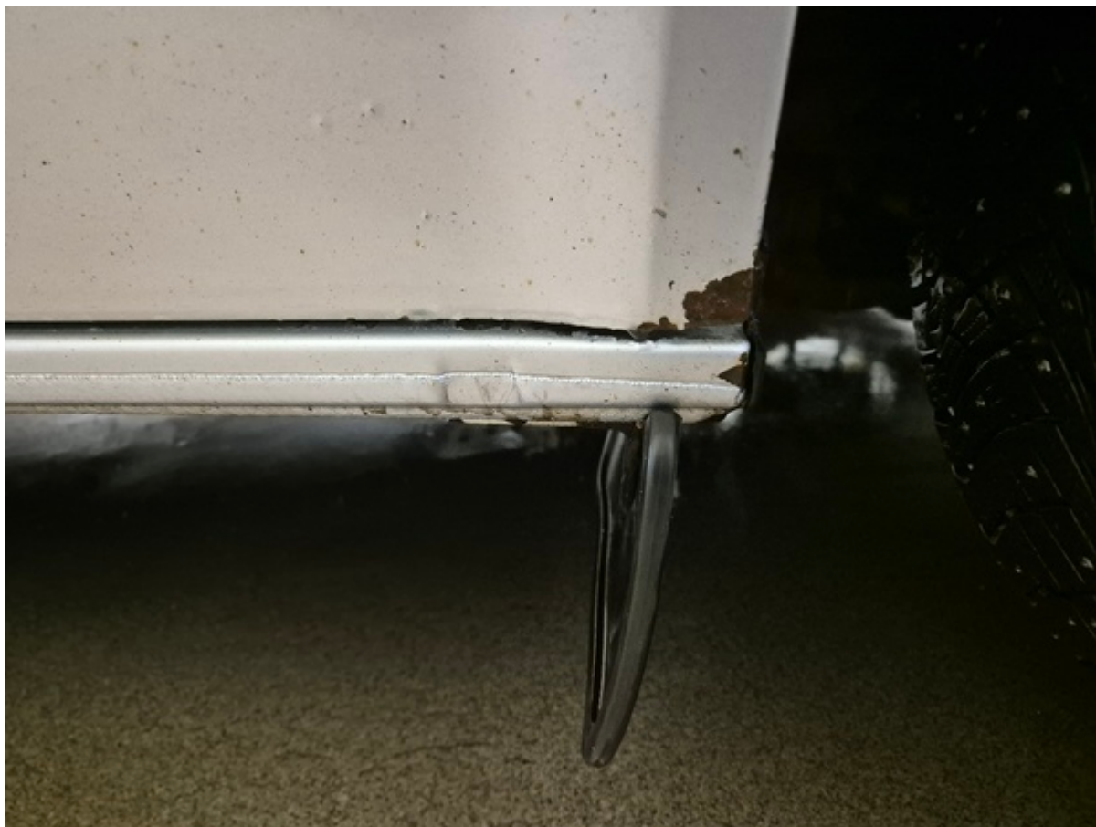
Trösklar Höger Övrigt Rost
