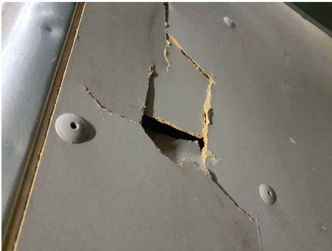
Damage 4: Sliding door, right: Sliding door (Verkleidung) - Broken / torn - Replace
