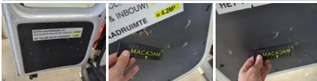
Boot door lining R, Crack, Replace
