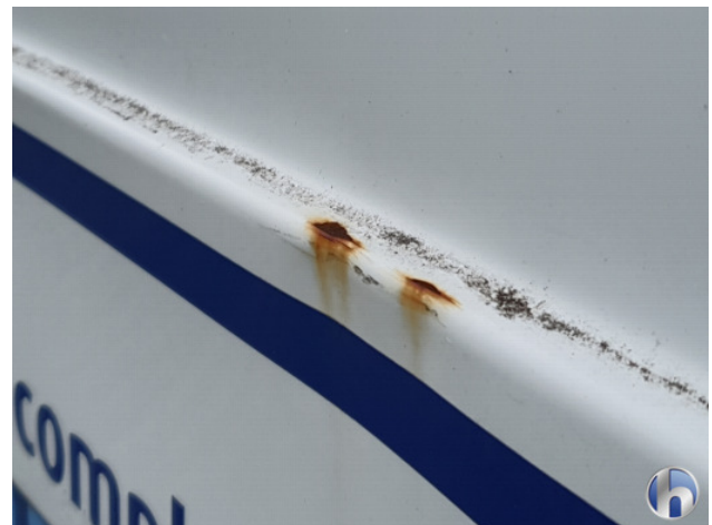
2. Zijwand - achter - Links Deuk/deuken - Herstellen
