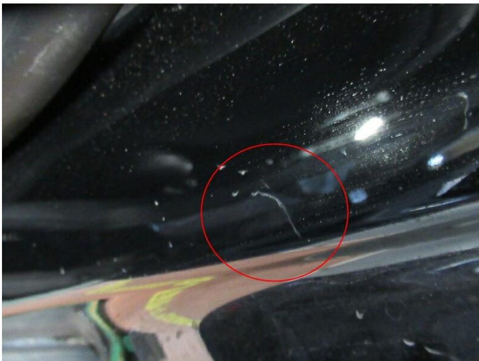
Bild 26 : Tür hinten links Einstieg, zerkratzt, smart repair
