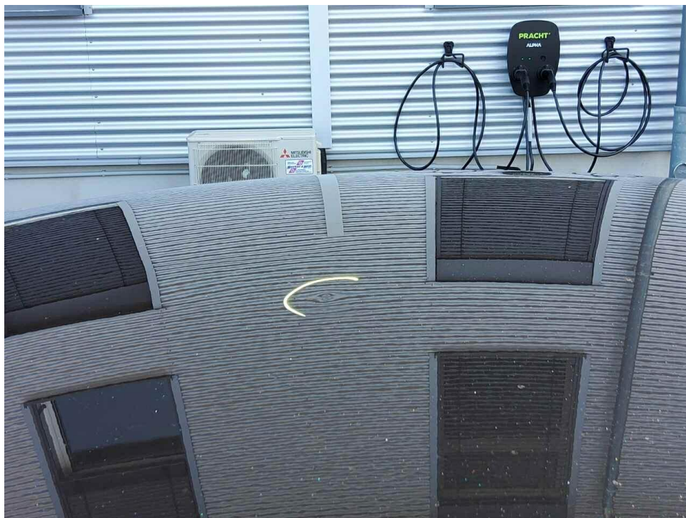
Bild 9 : Dach Delle
