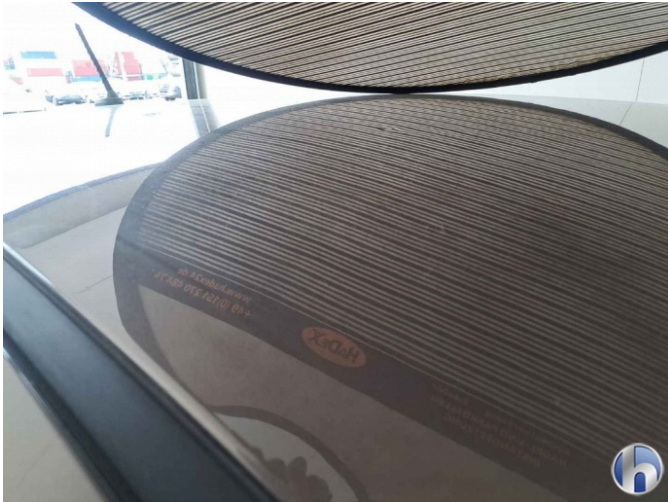
29. Dach mit 60 Dellen à 20-25mm
