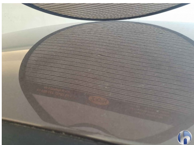
29. Dach mit 60 Dellen à 20-25mm
