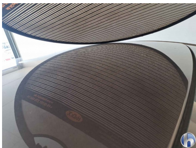
29. Dach mit 60 Dellen à 20-25mm
