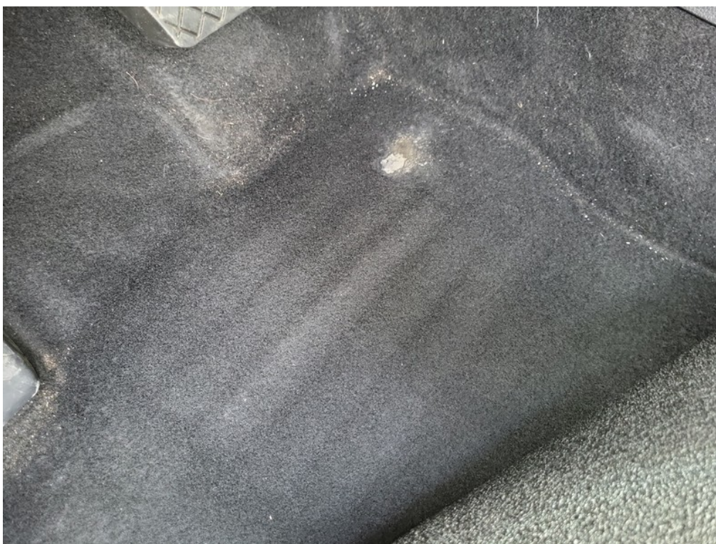
15 Koberec přední - Prasklina Umístění: Interiér (vnitřní prostor)
