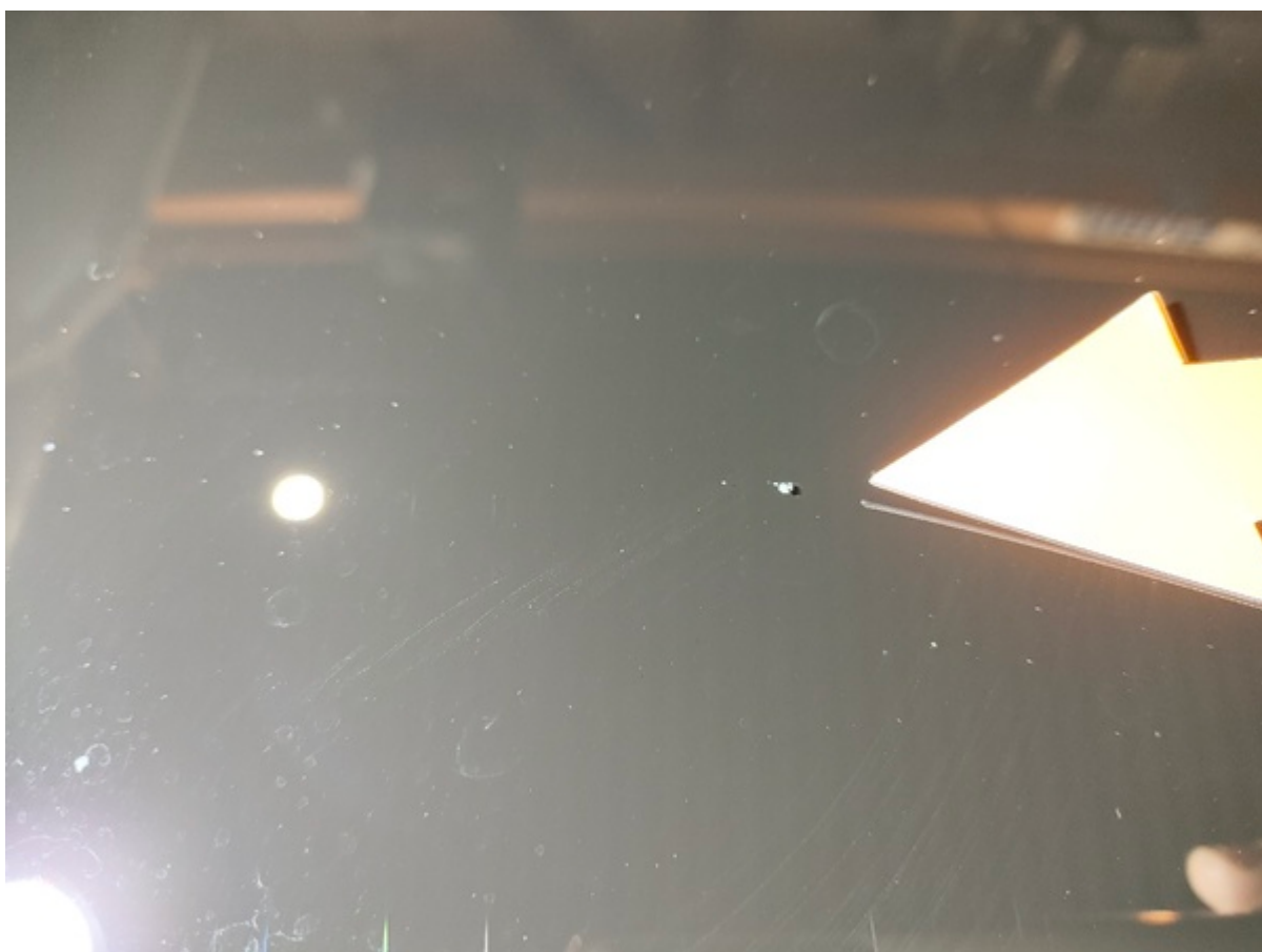
Tak Glastak Övrigt Stenskott
