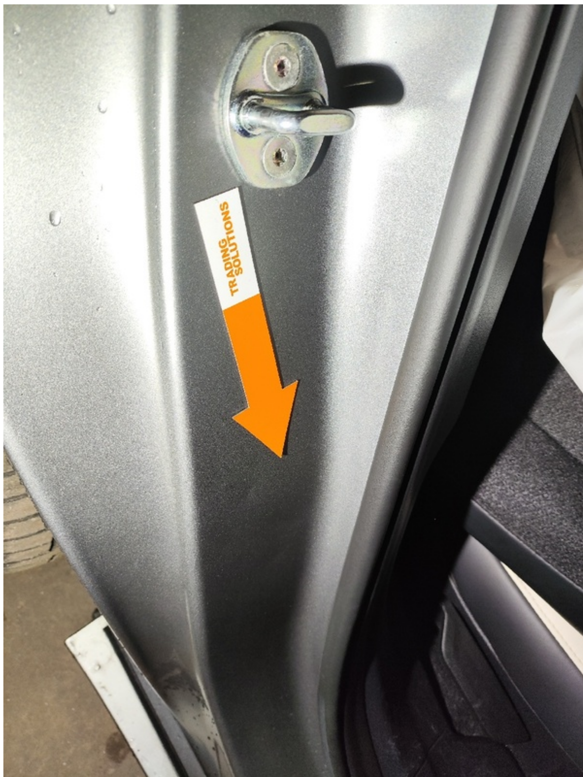
Övrigt Övrigt Övrigt Insteg höger bak små bucklor
